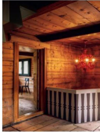
Sichtbarer Strickbau und aufgemaltes Treppengeländer im Obergeschoss
